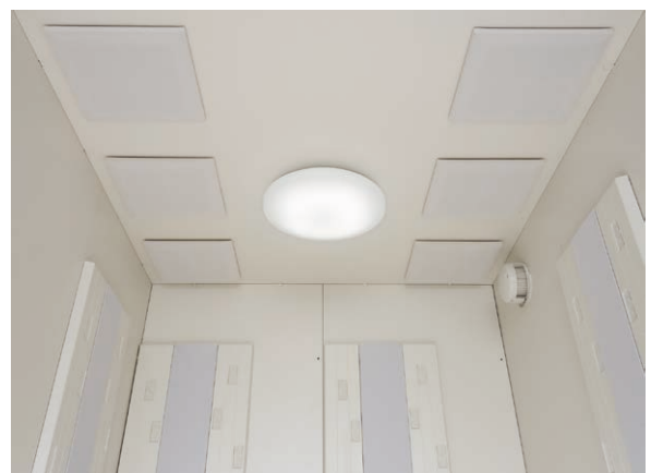
■音場天井パネル/照明器具
